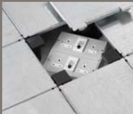
Slab box : RCD protection
